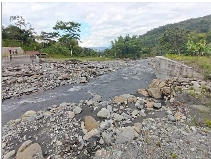
Foto 33: Río Blanco (colocación de puente Bayle)
